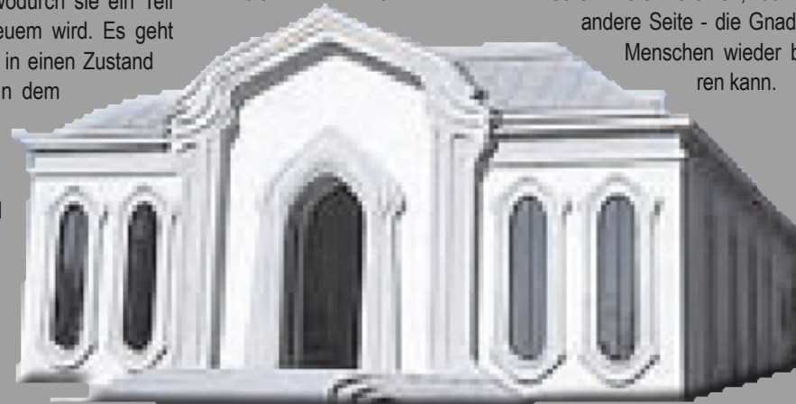
AUSSEGNUNGSHALLE - FASSADE, EGGENFELDEN Deutschland 1983; Fritz Hörauf
